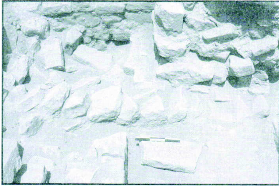
صورة رقم (٢٣) توضح كيفية سقوط الأحجار نتيجة الزلازل
