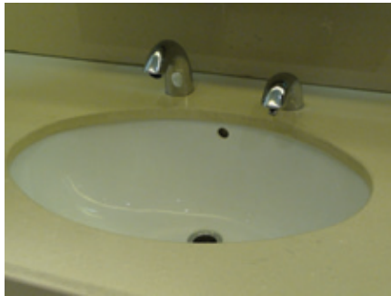
محبس يعمل عن طريق الاستشعار باستخدام الأشعة تحت الحمراء. وإلى يساره منفذ للصابون يعمل بنفس الطريقة
