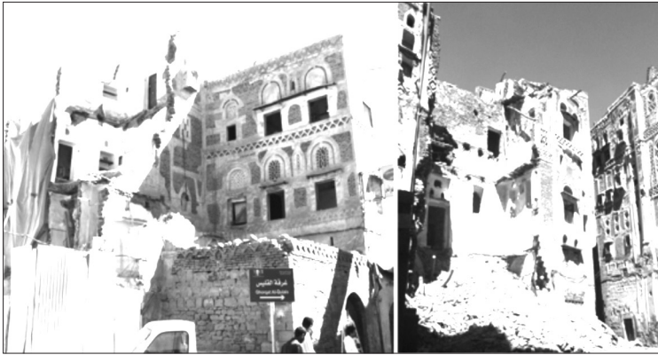
اللوحة رقم (٣): توضح تدهم المباني القديمة في المدينة (الباحث)
