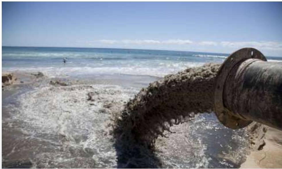
التلوث البحري نتيجة الصرف الصحي للمصانع
