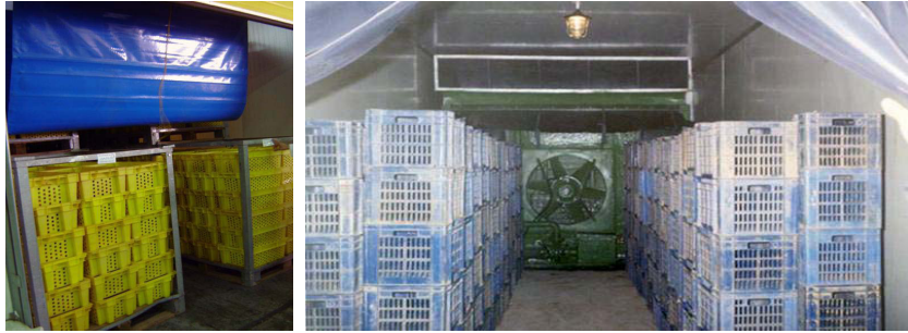
شكل (٨) غرف التبريد المبدئي وتظهر مراوح الهواء البارد المدفوع للتوزيع المنتظم لدرجة الحرارة بين عبوات المنتجات البستانية. (المصدر: تصوير المؤلفين).
