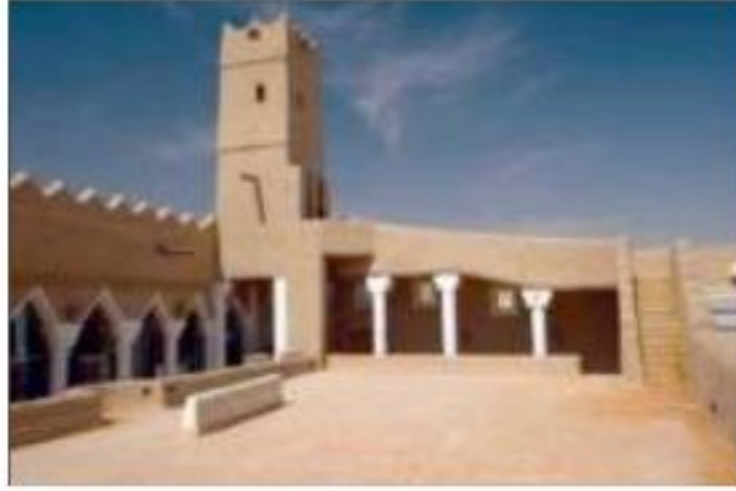
اللوحة رقم (٩) : توضح مسجد الظويهرة بحي البجيري بعد الترميم (هيئة تطوير الرياض)
