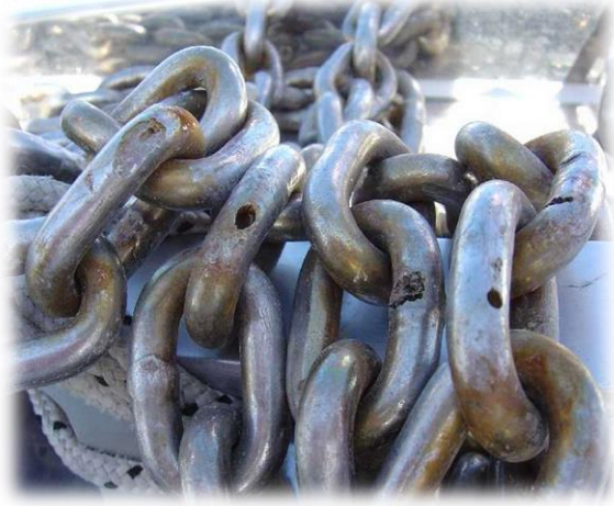
شكل (٣٠) التآكل النقري (Pitting Corrosion) www.nauticclub.net
