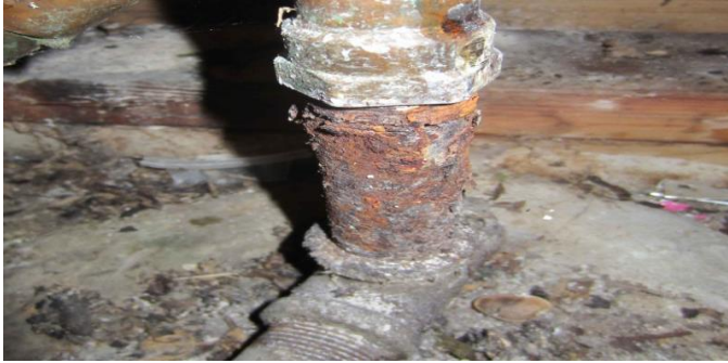
شكل (٢٣) التآكل الجلفاني - Galvanic Corrosion
