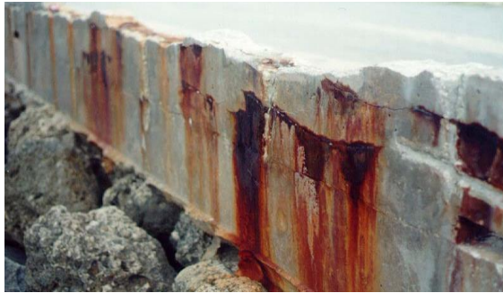
شكل (٥) تآكل الخرسانة
