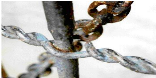
شكل (٤) تآكل الاحتكاك (Fretting Corrosion)
