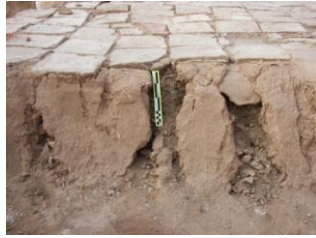
الشكل رقم (4): هبوط الجزء الجنوبي من المصطبة. الشكل رقم (5): هروب أرضية المصطبة بفعل مياه الأمطار.
