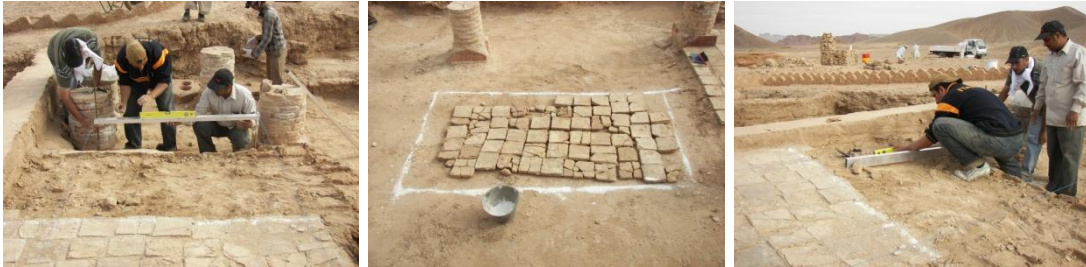
الشكل رقم (33): مراحل تدعيم أرضية المصطبة.
