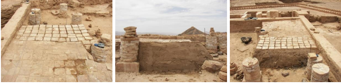
الشكل رقم (34): مراحل إعادة تثبيت بلاطات المصطبة.
