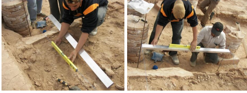
الشكل رقم (32): طريقة ضبط مستوى سطح المصطبة.
