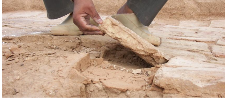
الشكل رقم (8): إمكانية فصل بلاطات المصطبة بسهولة باليد.
