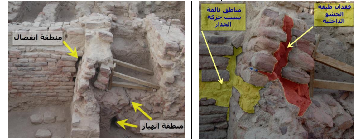
الشكلان رقم (10-11) حالة الجدار الفعلية من ضعف وتهديد بالانهيار
