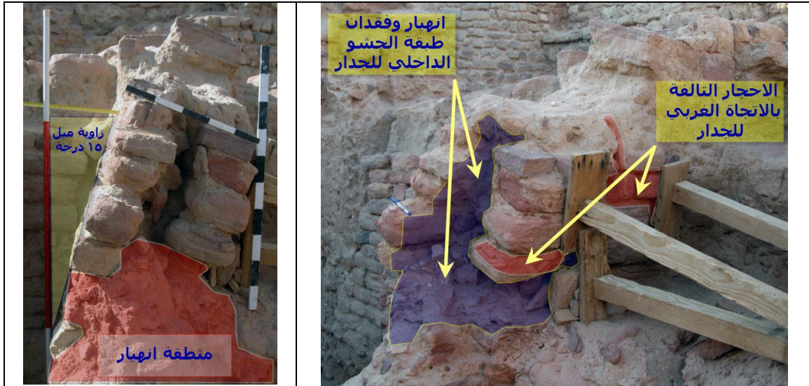
الشكل رقم (13) زاوية الميل للجدار
