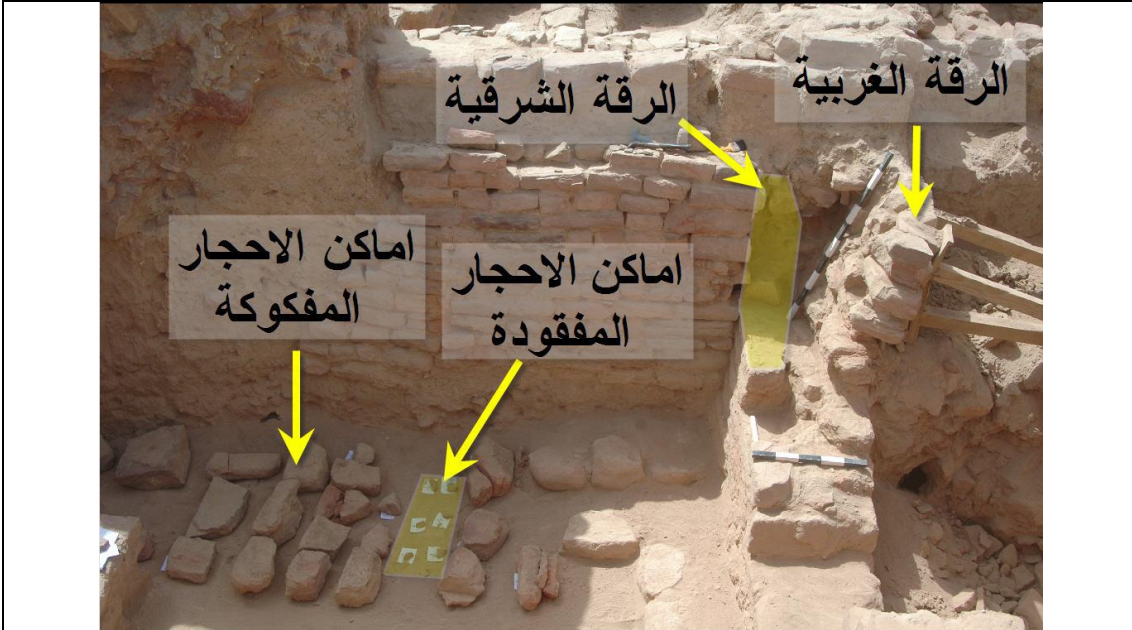
الشكل رقم (47) حالة الجدار بعد فك الرقعة الشرقية منه.
