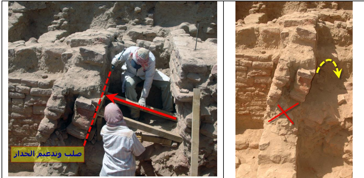
الشكل رقم (9) صلب وتدعيم الجدار المائل
