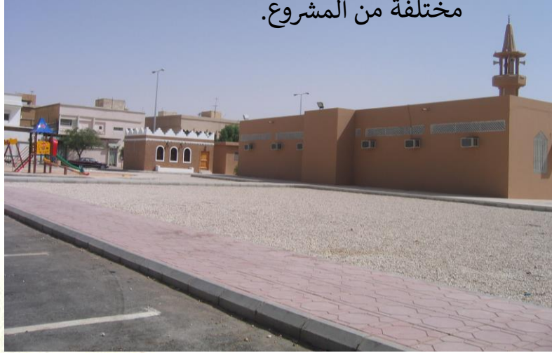
المسجد يتوسط المشروع، ويظهر على يساره غرفة مركز الحي، وعلى يسارها منطقة المسطحات الخضراء وملاعب الأطفال، وجزء من الأرصفة حديث التنفيذ والسفلة المجددة ومواقف السيارات المستحدثة.
