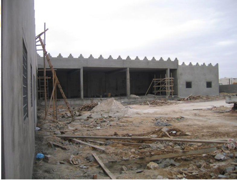
المشروع أثناء مرحلة التنفيذ ويظهر جزء من مبنى ورشة الصيانة
