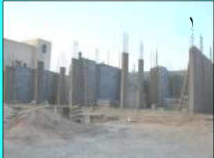
مباني قيد الانشاء ( تطور عمراني)
